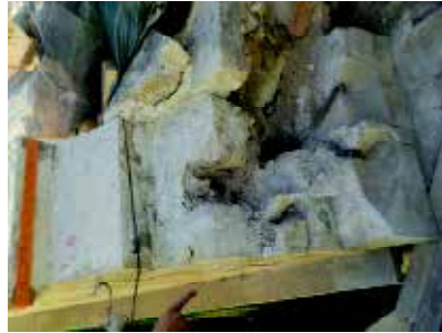
נעילת אבני הגמלון בחזית הכניסה של בניין 13 בעזרת "קלמרה" בצורת אומגה
