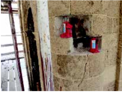
מערכת המתיחה החלודה במגדל השעון - יפו
